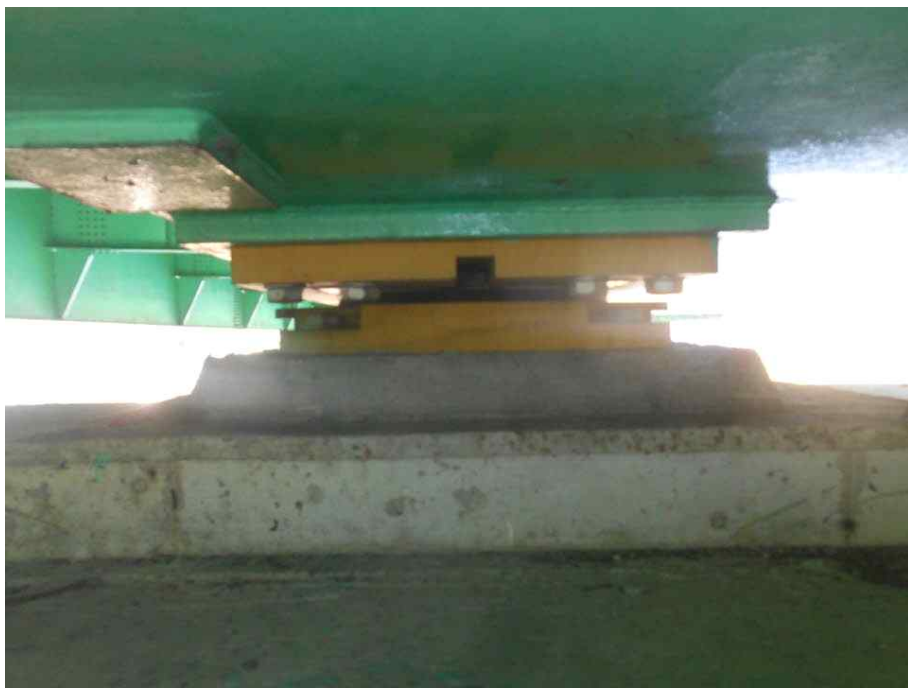
받침장치 전경 (가동단)
