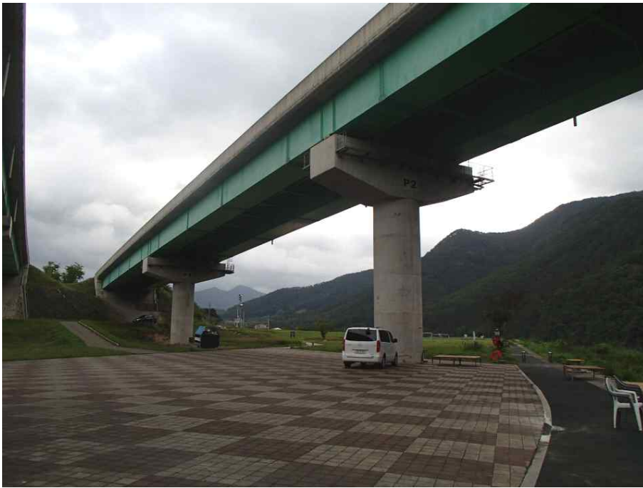
Steel Box Girder 외부 전경
