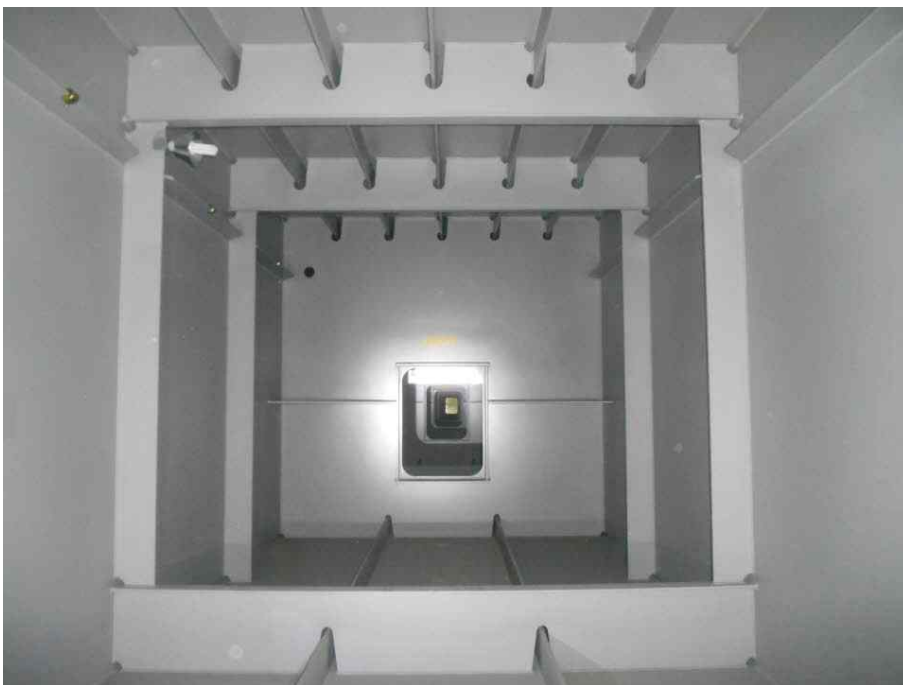
Steel Box Girder 내부 전경
