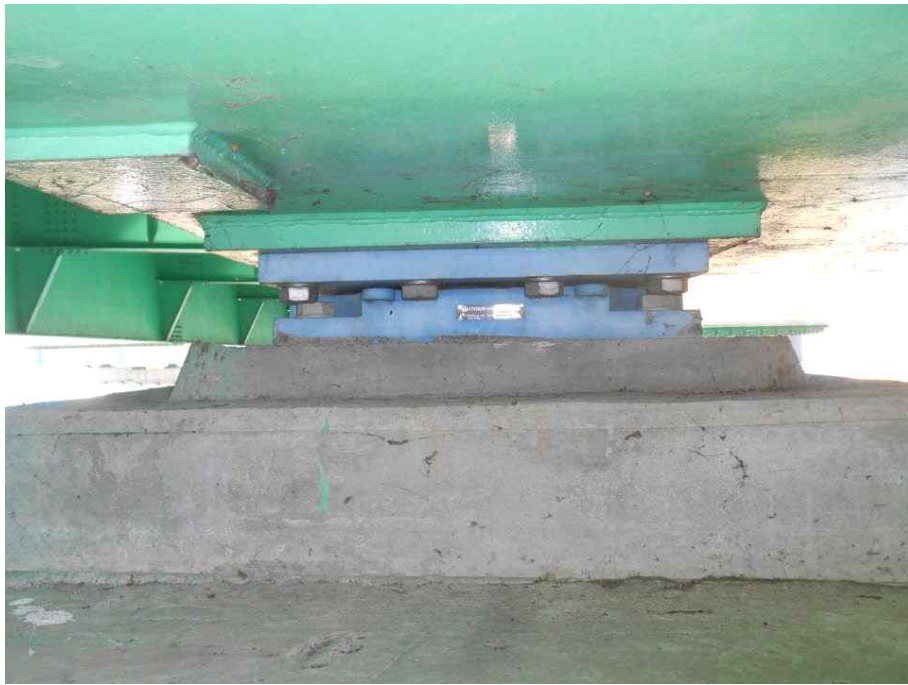
받침장치 전경 (고정단)
